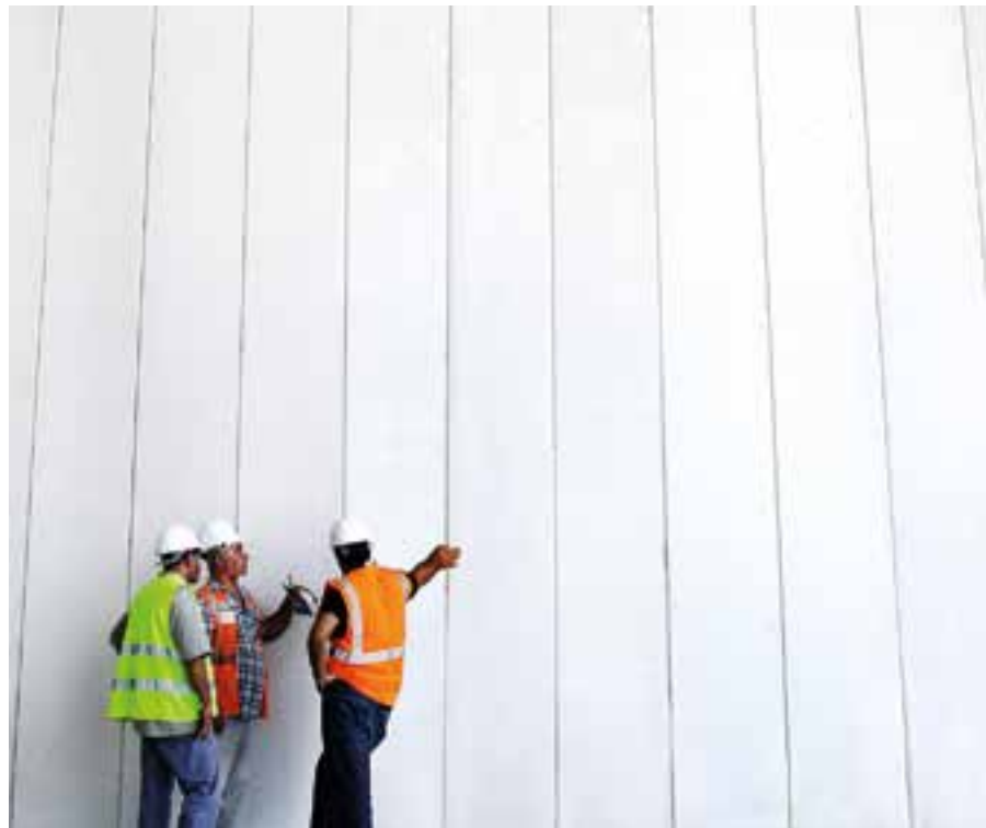
15 cm kalınlıktaki Ytong yangın duvarı ile 6 saate kadar yangın dayanımı sağlanabilir.
